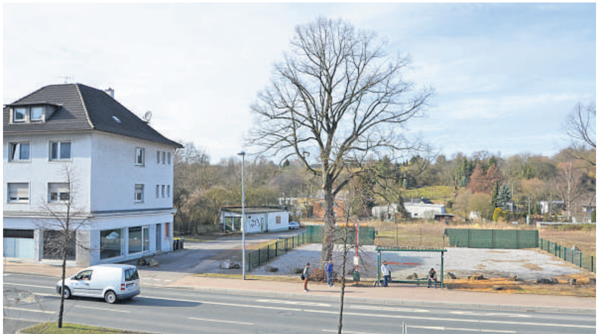
Auf diesem Grundstück an der Hauptstraße in Westig entstehen der neue Penny-Markt sowie ein Trinkgut-Markt. In das Gebäude links zieht die Sparkassen-Filiale.
