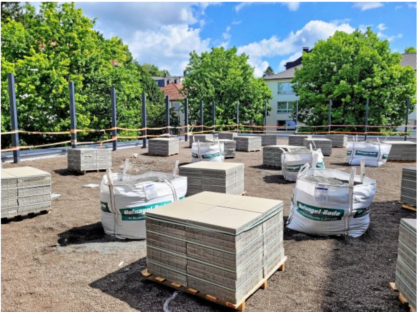
Die zweite Terrasse der Kita befindet sich in 15 Metern Höhe auf dem Flachdach des Gebäudekomplexes. Foto: Yvonne Hinz
